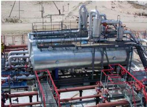
Нефтегазовый сепаратор (НГС) -
