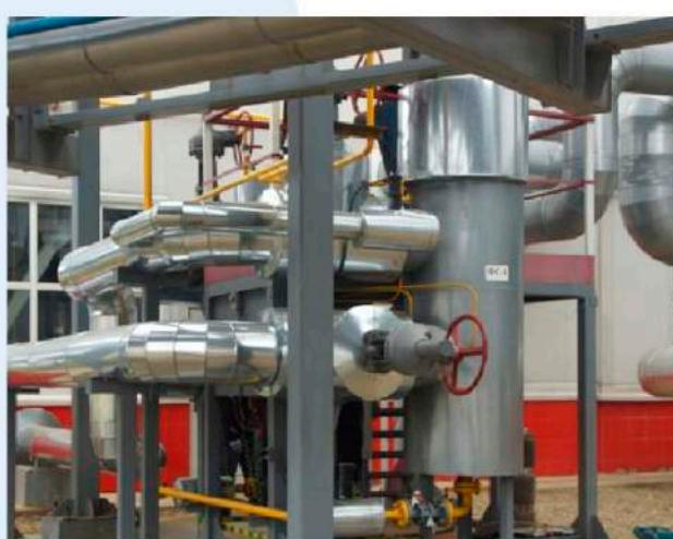
**Газовый фильтр сепаратор
